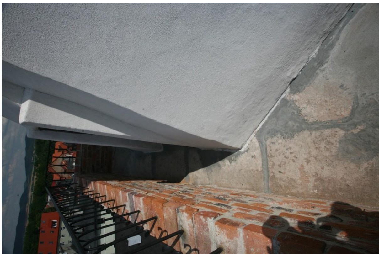
Fot. 8. Bystrzyca Kłodzka, Wieża Bramy Kłodzkiej, ganek obejścia hełmu – strona zachodnia.
