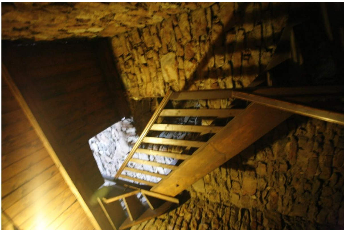
Fot. 15. Bystrzyca Kłodzka, Wieża Bramy Kłodzkiej, poziom + 11,10 – zablokowany otwór okienny w ścianie północnej.
