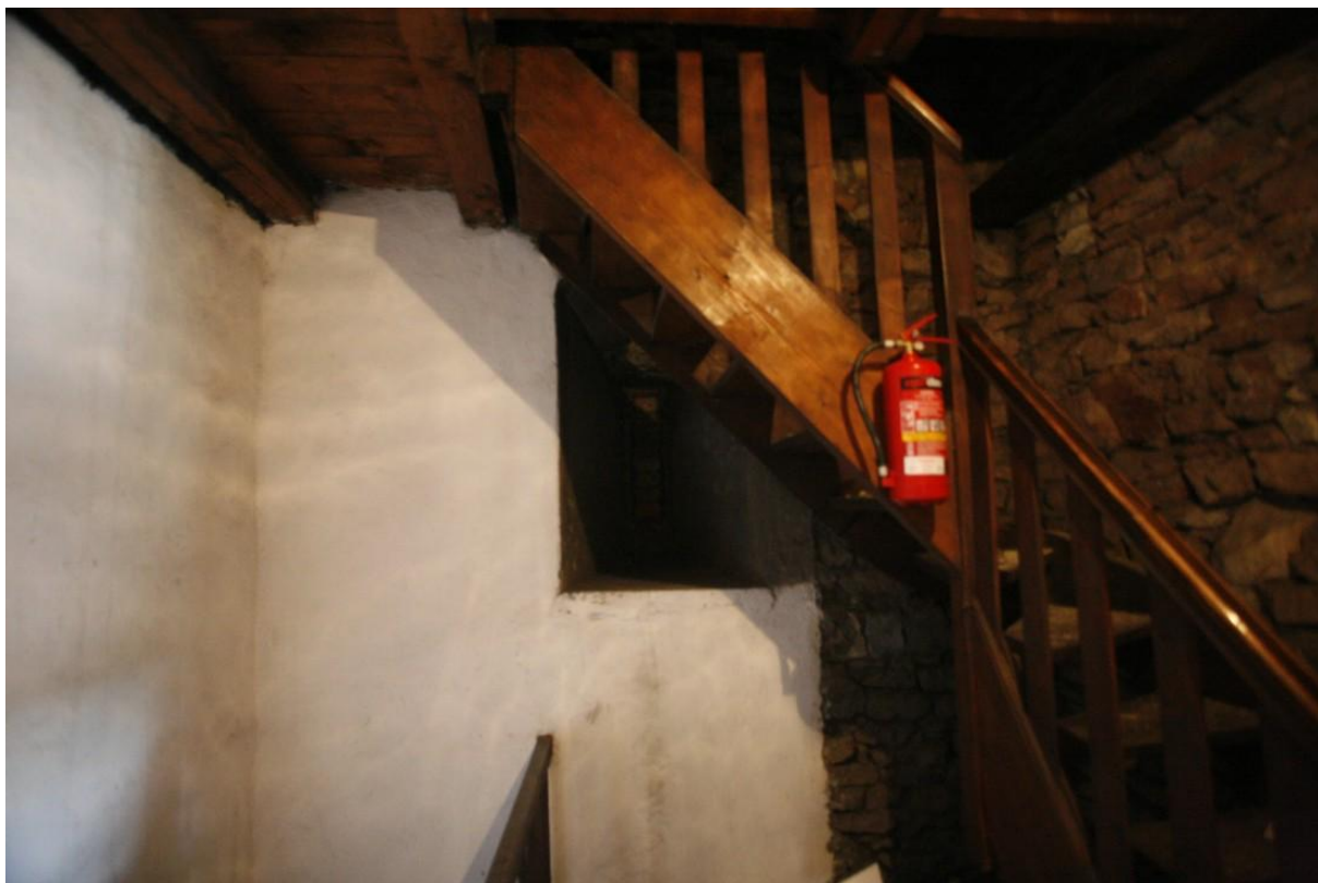
Fot. 14. Bystrzyca Kłodzka, Wieża Bramy Kłodzkiej, poziom + 8,15 – zablokowany otwór okienny w ścianie północnej.
