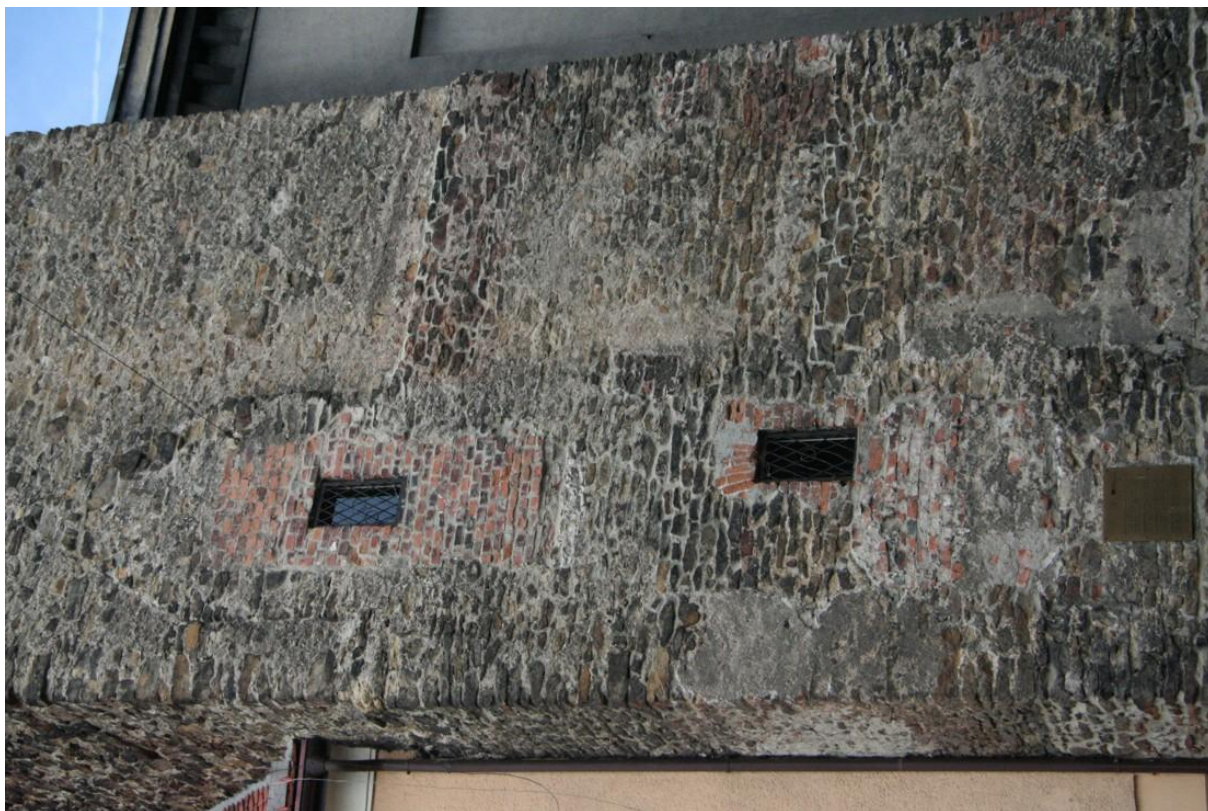
Fot. 5. Bystrzyca Kłodzka, Wieża Bramy Kłodzkiej, elewacja wschodnia – relikw skutego muru bramy oraz ganka.
