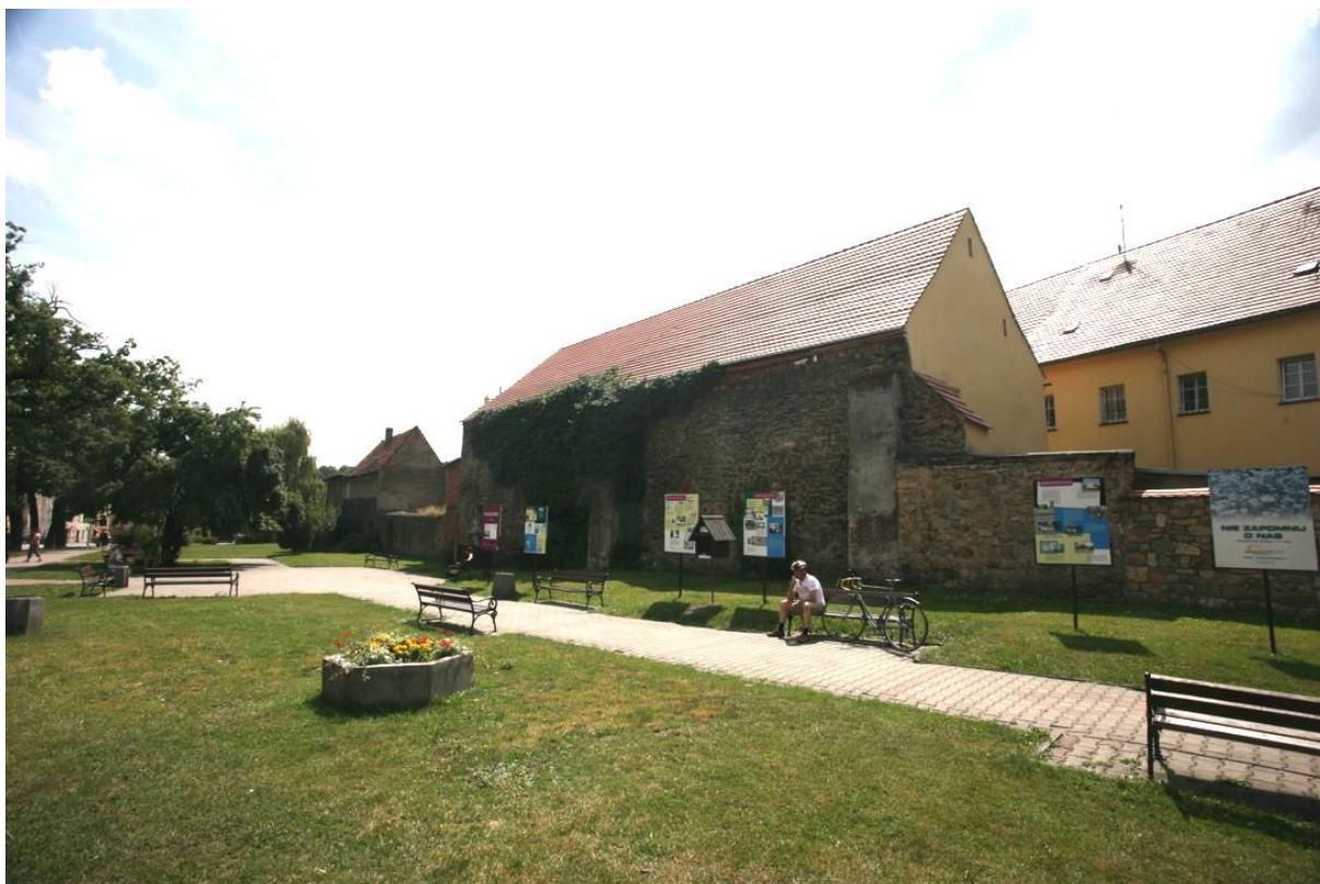
Fot. 23. Bystrzyca Kłodzka, mur wzdłuż ul. Wojska Polskiego, fragment na tyłach budynków przy placu Marii Skłodowskiej-Curie (1).
