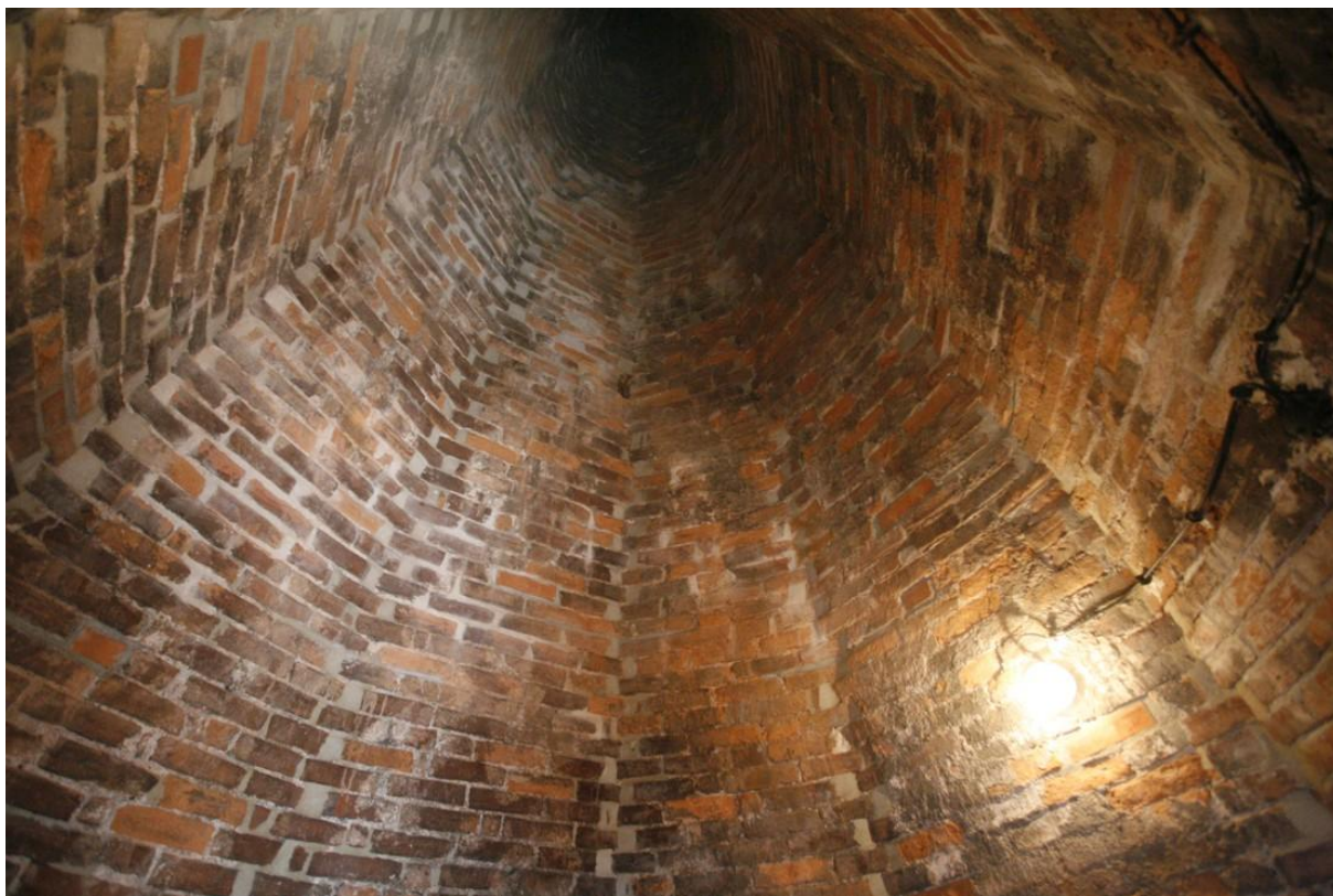
Fot. 22. Bystrzyca Kłodzka, Wieża Bramy Kłodzkiej, poziom + 19,20 – wnętrze helmu.
