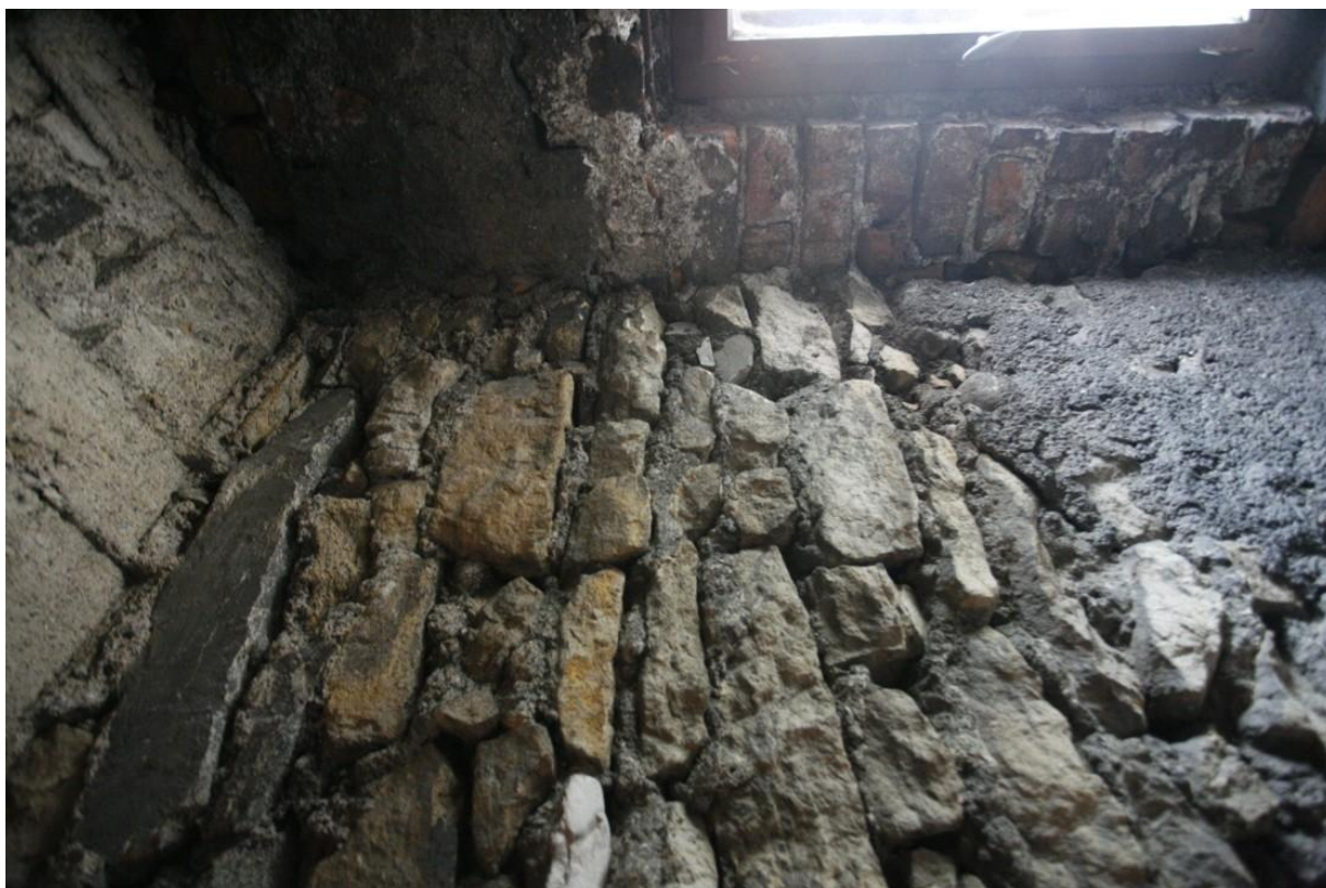
Fot. 13. Bystrzyca Kłodzka, Wieża Bramy Kłodzkiej, poziom + 8,15 – zablokowany otwór wejścia na ganek, ościeże północne.
