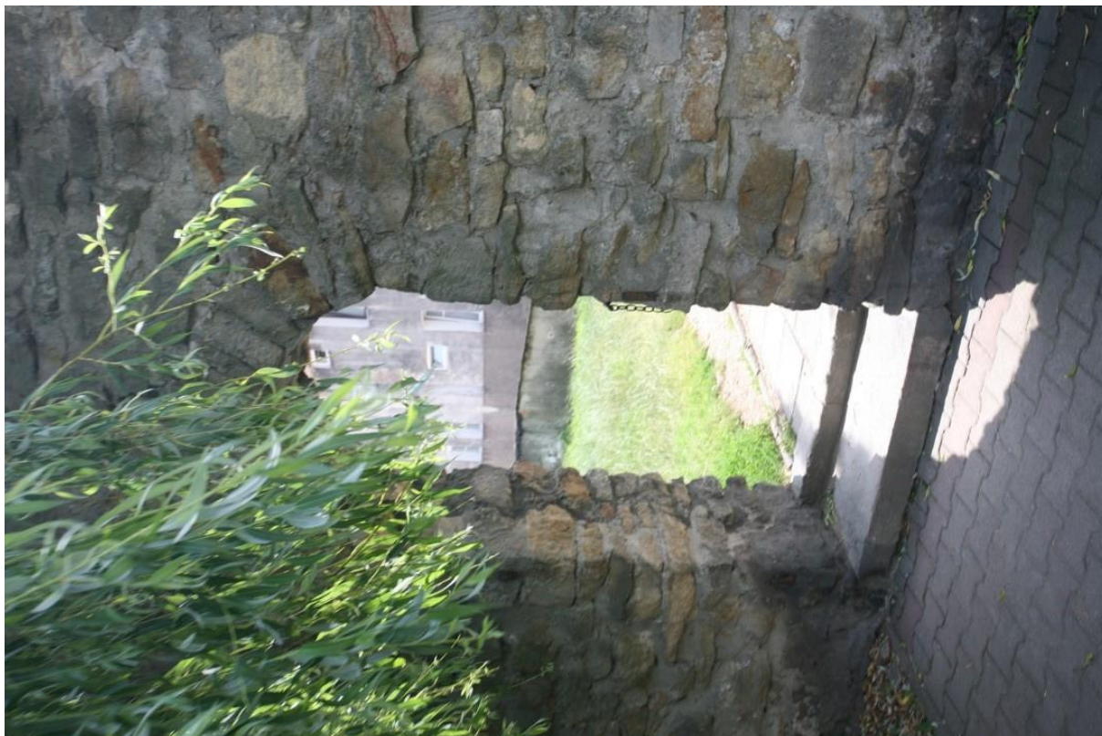
Fot. 29.. Bystrzyca Kłodzka, mur wzdłuż ul. Wojska Polskiego, fragment na tyłach budynków przy ulicy Siennej – wtórnie przebitý otwór przejścia (2).
