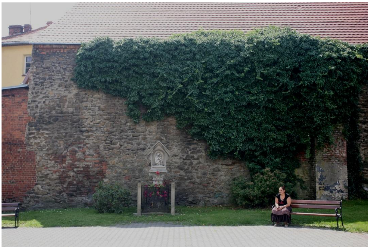
Fot. 24. Bystrzyca Kłodzka, mur wzdłuż ul. Wojska Polskiego, fragment na tyłach budynków przy placu Marii Skłodowskiej-Curie.
