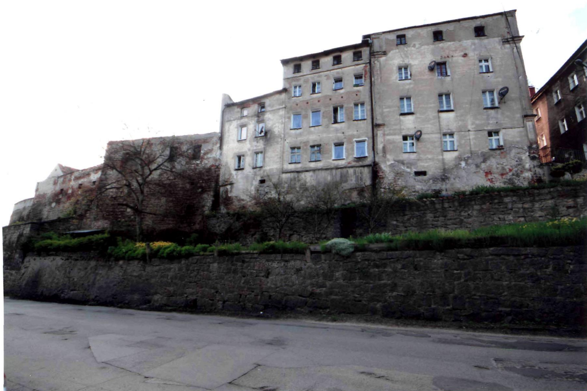
FOT.1. BYSTRZYCA KŁODZKA, MURY MIEJSKIE, ODCINEK A-B.
