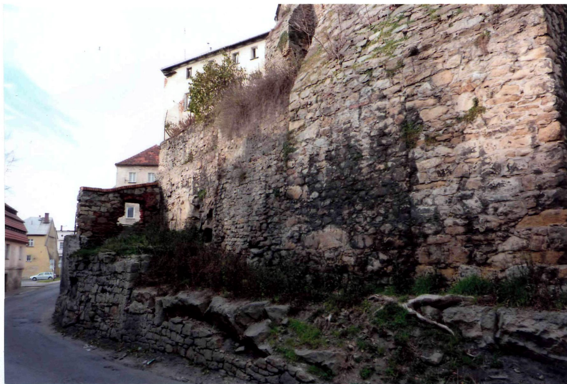
FOT. 23. MURY MIEJSKIE, ODCINEK G-H.
