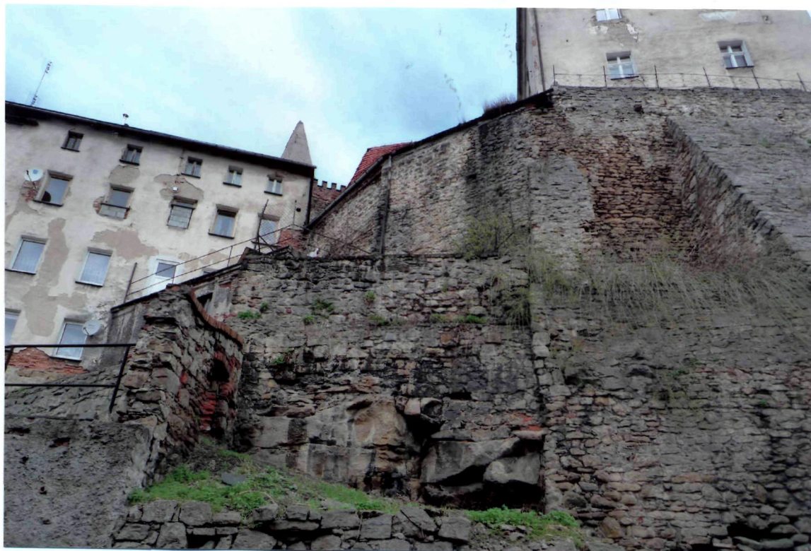
FOT. 25. MURY MIEJSKIE, ODCINEK G-H.
