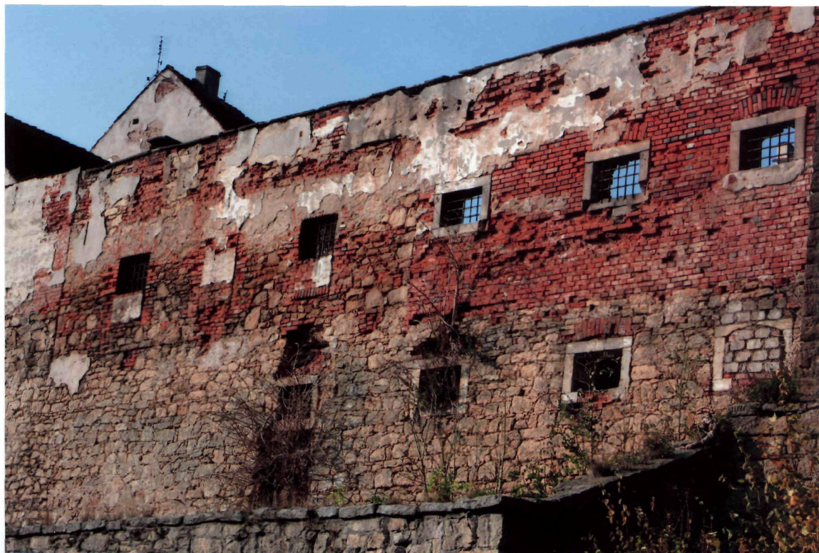
FOT. 7. WĄTEK CEGLANY I KAMIENNY, ŚCIANA DAWNEGO WIĘZIENIA, FRAGMENT, OCINEK C-D.
