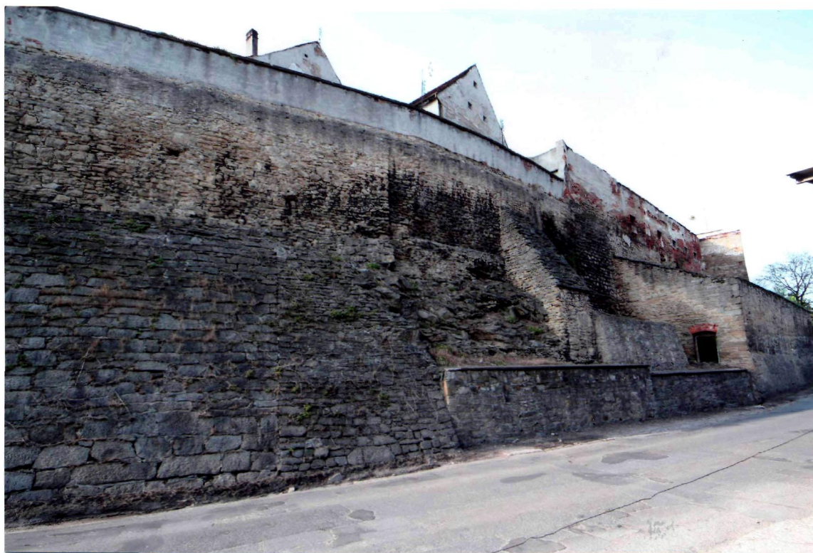
FOT. 14. MURY MIEJSKIE, ODCINEK D-F, WIDOK W KIERUNKU PÓŁNOCNO-WSCHODNIM.
