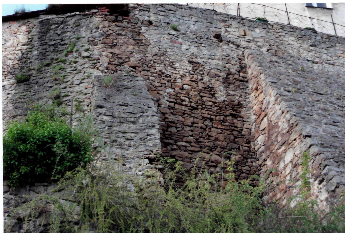
FOT. 24. ROŚLINNOŚĆ PORASTAJĄCA KAMIENNE MURY, ODCINEK G-H, FRAGMENT.
