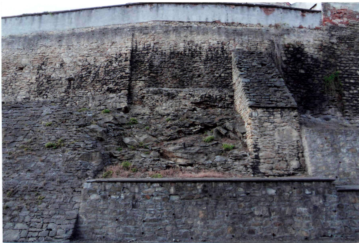
FOT. 15. MURY MIEJSKIE, ODCINEK D-E.
