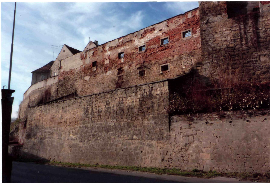
FOT. 5. ZESPÓŁ BUDYNKÓW DAWNEGO WIĘZIENIA, MURY MIEJSKIE, ODCINEK C-D.
