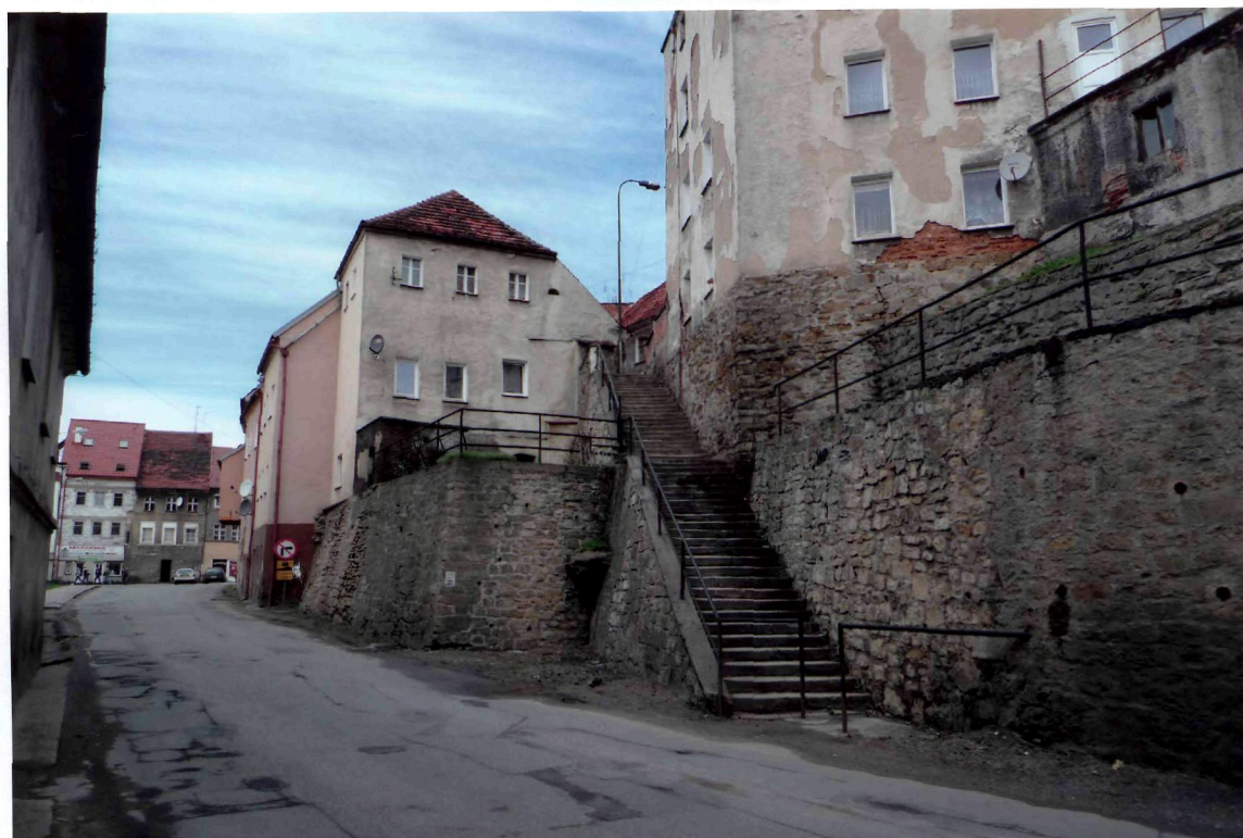
FOT. 28. MURY OPOROWE PRZY UL. PODMIEJSKIEJ, ODCINEK H-J, WIDOK W KIERUNKU ZACHODNIM.
