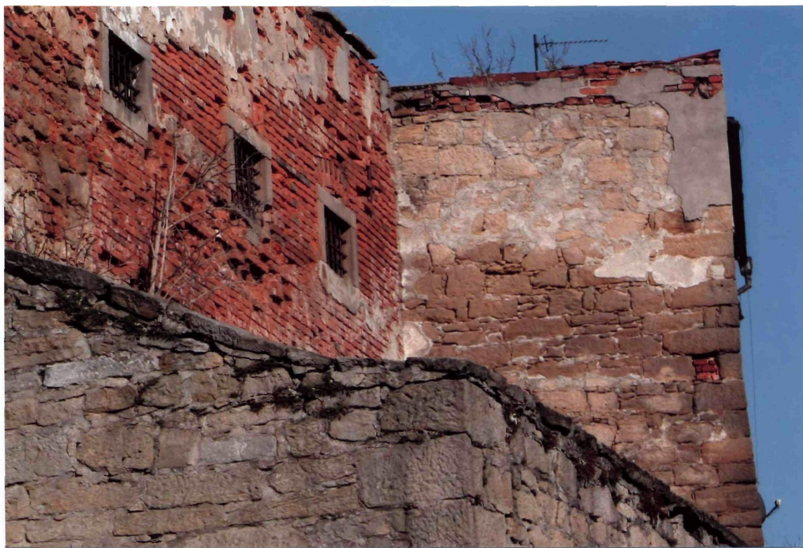
FOT. 6. ODCINEK B-C, FRAGMENT, WIDOK NA ZACHODNIĄ ŚCIANĘ POŁUDNIOWO-WSCHODNIEGO BUDYNKU WIĘZIENIA.
