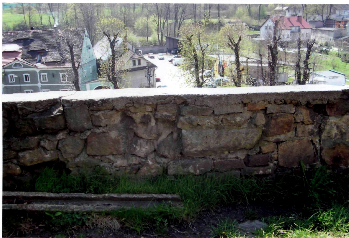
FOT. 36. KAMIENNY WĄTEK, WEWNĘTRZNA STRONA MURÓW, ODCINEK F-G, FRAGMENT.
