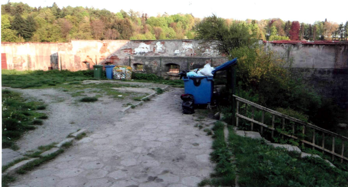
FOT.31. WEWNĘTRZNA STRONA MURÓW, ODCINEK B-D, ŚCIANY BUDYNKÓW DAWNEGO WIĘZIENIA.
