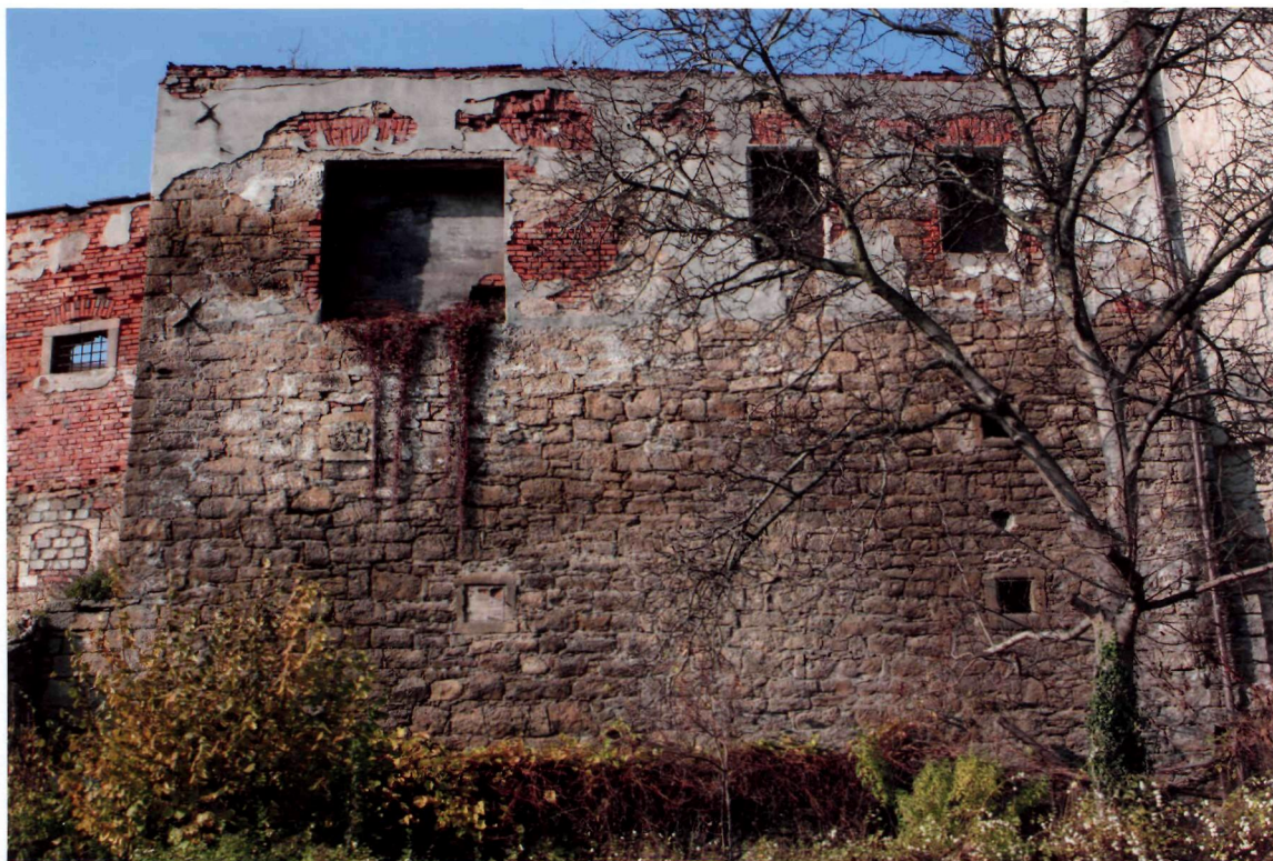
FOT. 3. POŁUDNIOWO-WSCHODNIA CZĘŚĆ BUDYNKU DAWNEGO WIĘZIENIA, MURY MIEJSKIE, ODCINEK B-C.
