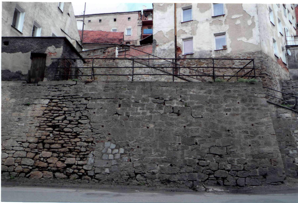
FOT. 30. MUR OPOROWY, ODCINEK I-J.
