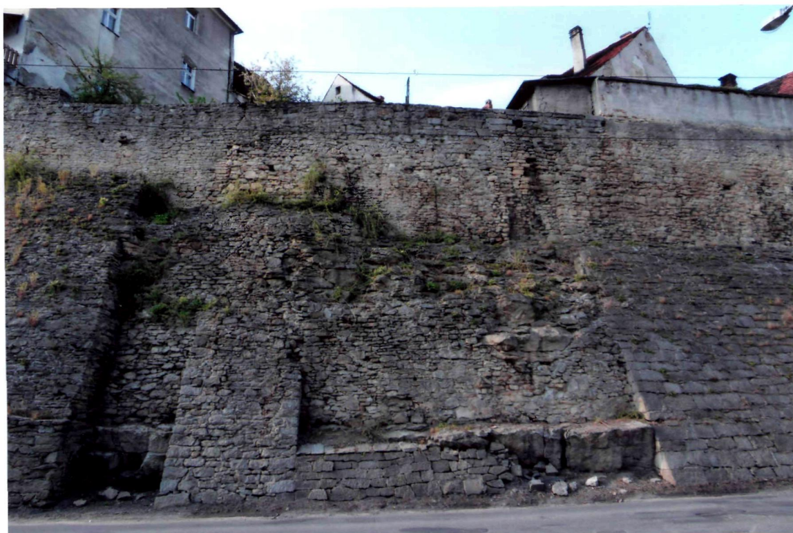
FOT. 18. SKARPA OBLICOWANA KAMIENIEM I WZMOCNIONA PRZYPORAMI, ODCINEK F-G.
