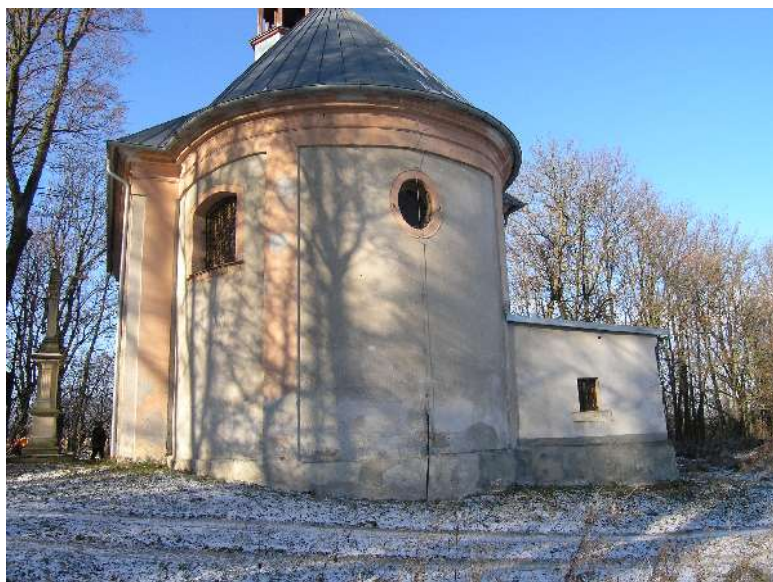
Fot. 2 Elewacja wschodnia
