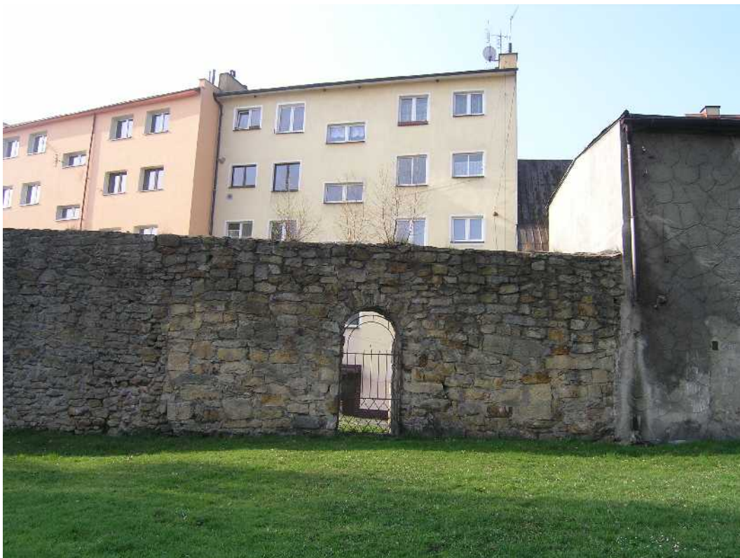
Fot. 8. Odcinek F-G. Widok od północy.
