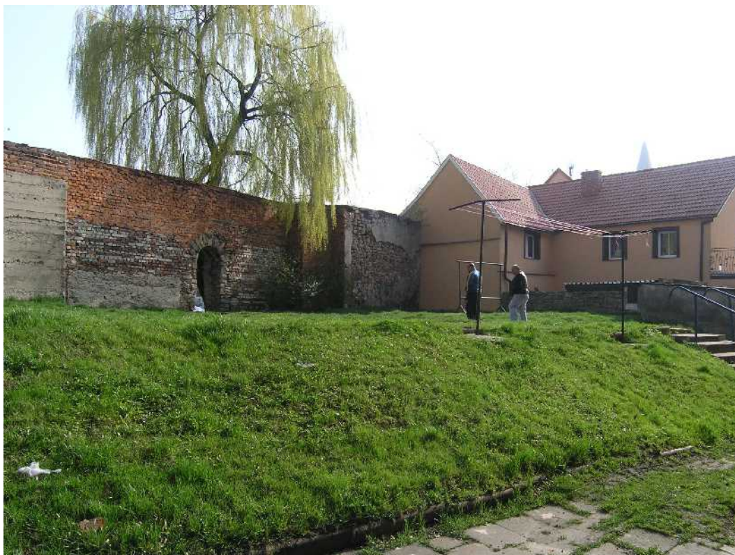
Fot. 6. Odcinek E1-E2-E3-F. Widok od południa.
