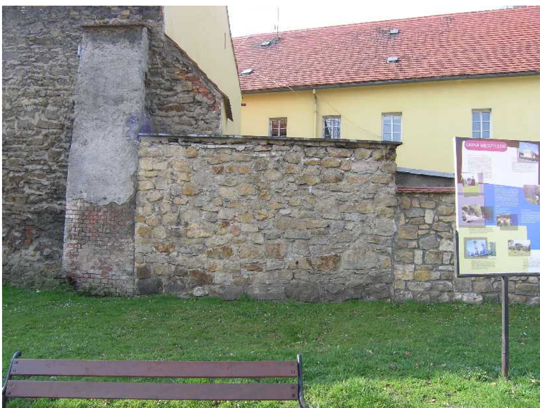
Fot. 17. Odcinek L-M
