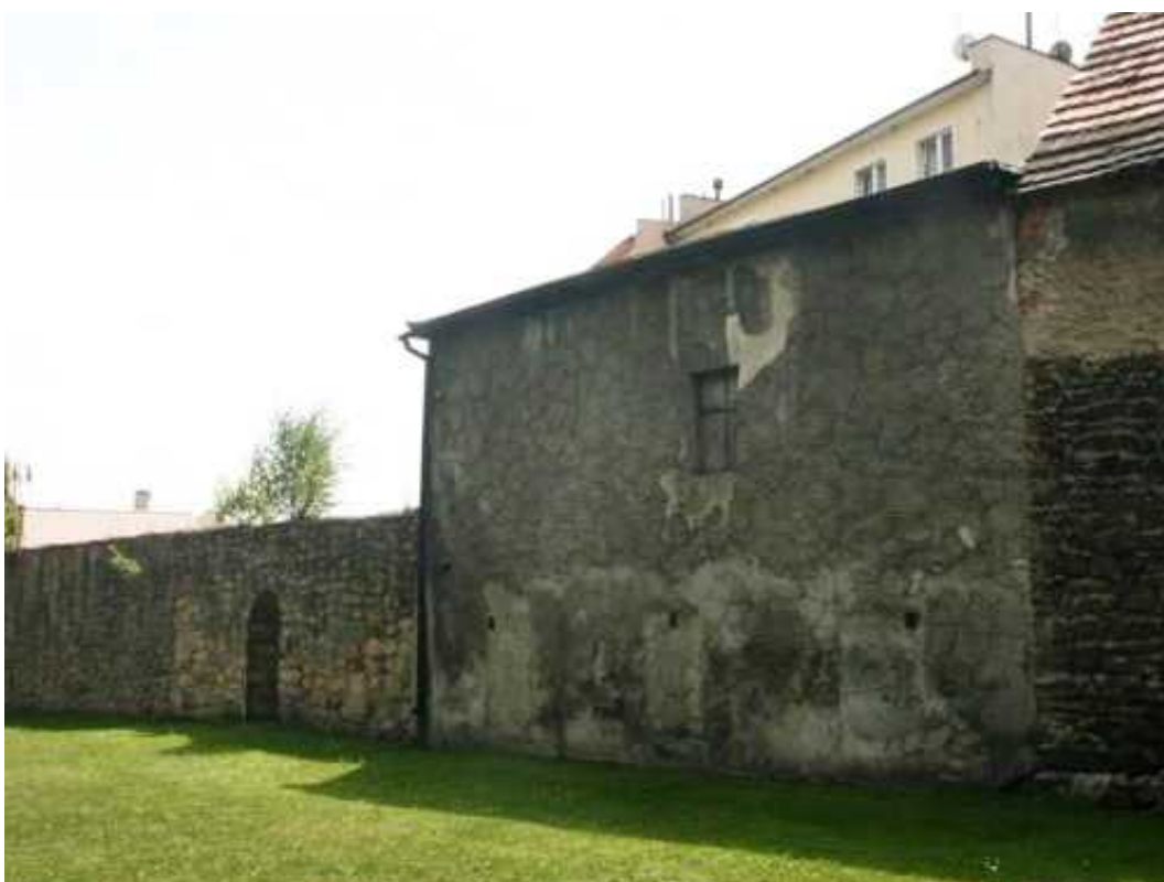
Fot. 9. Odcinek G-H.
