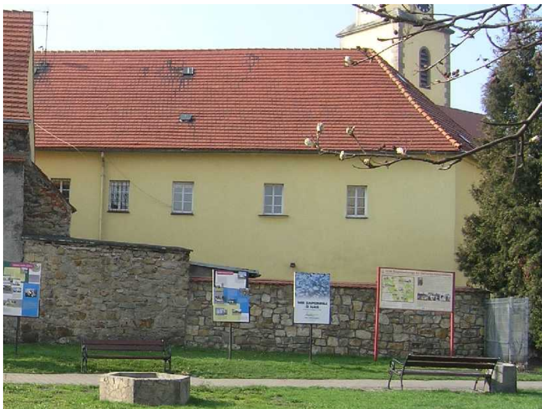
Fot. 18. Odcinek L-M-N
