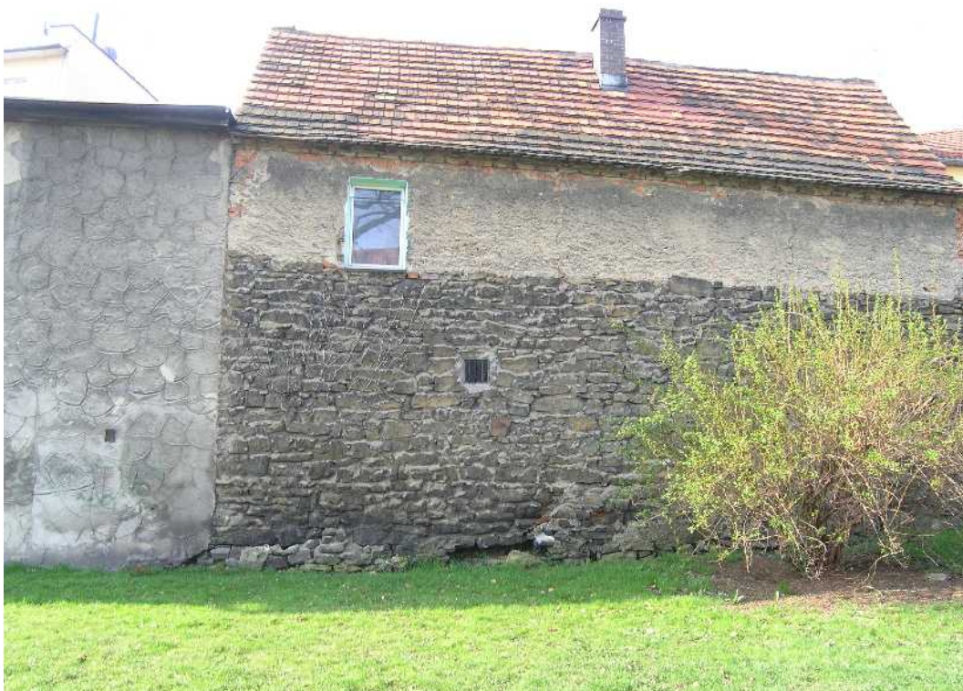
Fot. 10. Odcinek H-I.
