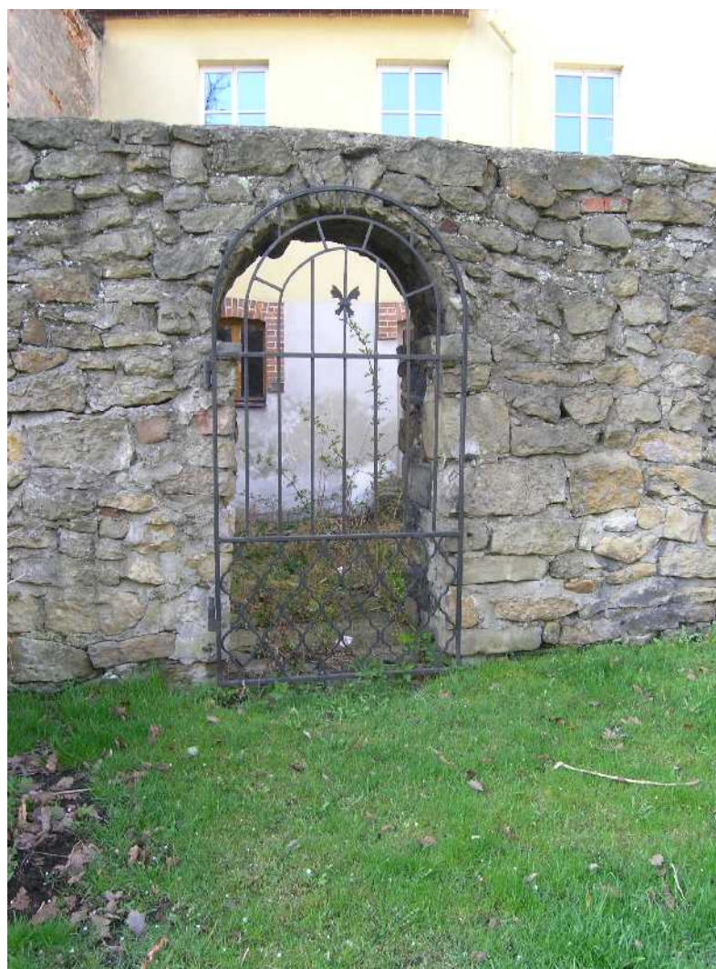
Fot. 13. Przejście w budynku na odcinku I-J.
