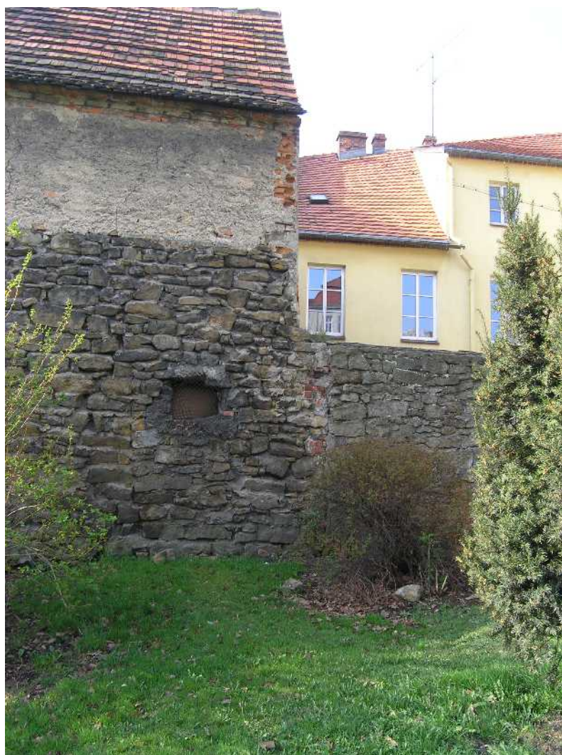
Fot. 11. Narożnik budynku w rejonie punktu I.
