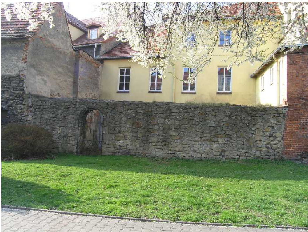
Fot. 12. Odcinek I-J.
