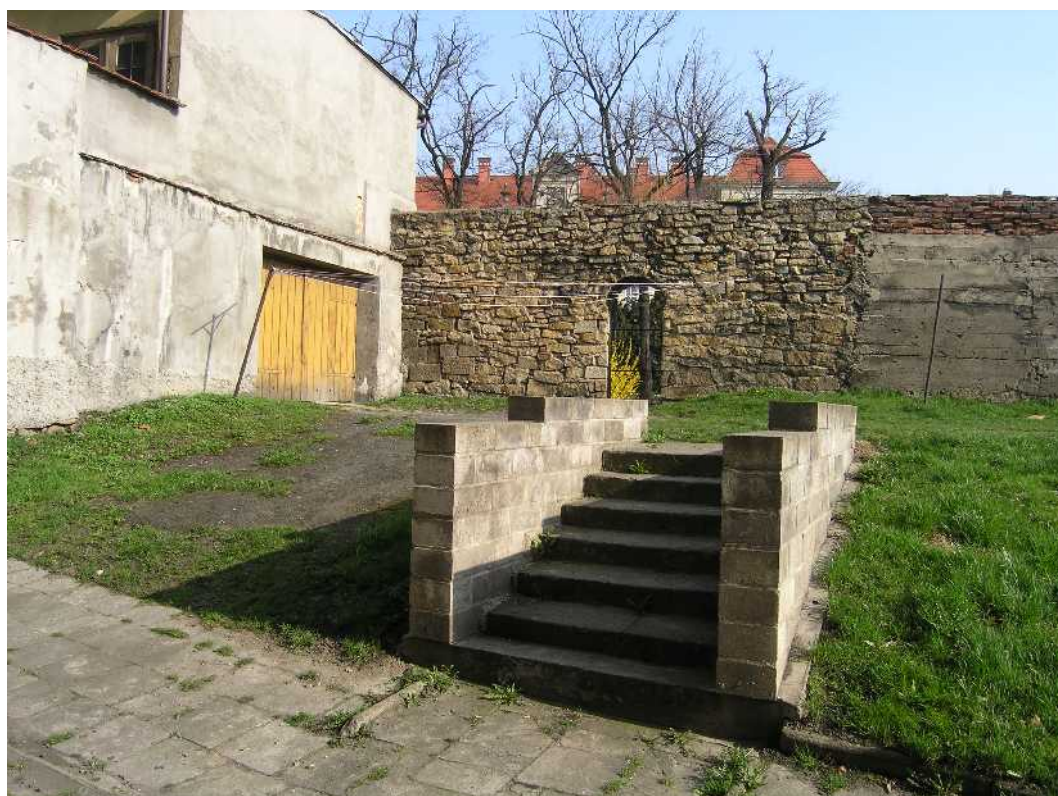
Fot. 7. Odcinek F-G. Widok od południa.
