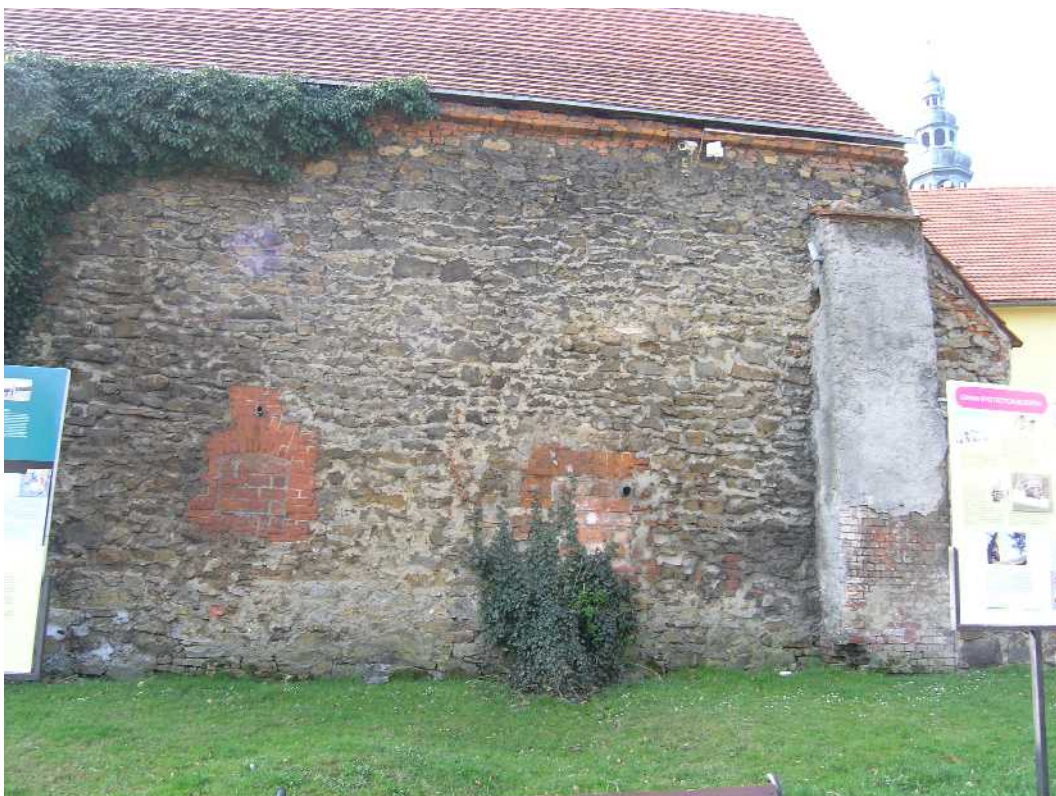
Fot. 16. Odcinek K-L część wschodnia
