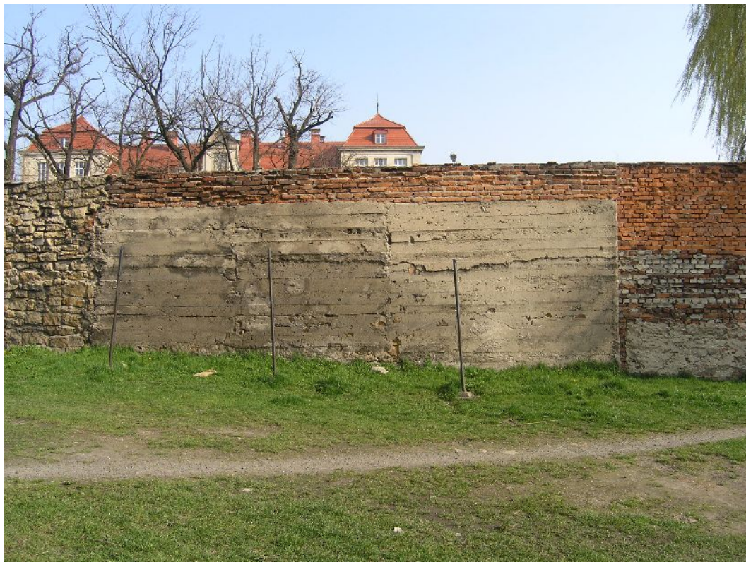
Fot. 15. /E-F/ Betonowe wzmocnienie muru od strony południowej, widoczne zniszczenia korony.
