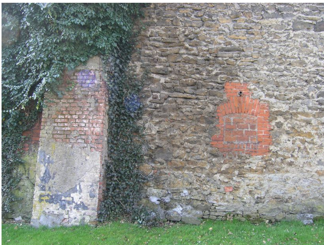
Fot. 22. /K-L/ Cokół rozwarstwiony, luźne kamienie, brak tynku na przyporze – zagrzybiony. Glony w cieniu bluszczu.
