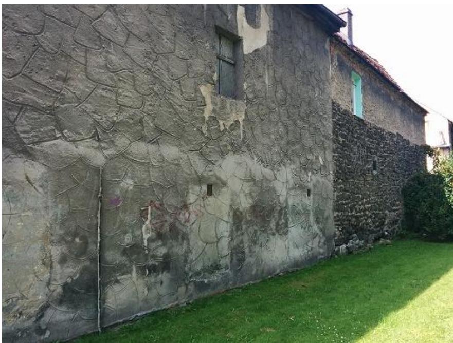
Fot. 27. Mur przy ul. Wojska Polskiego – widok ogólny
