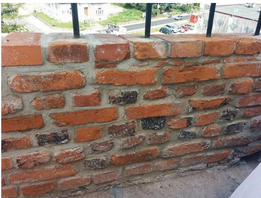
Fot. 8. Ceglany mur zwieńczenia wieży z cementową spoiną
