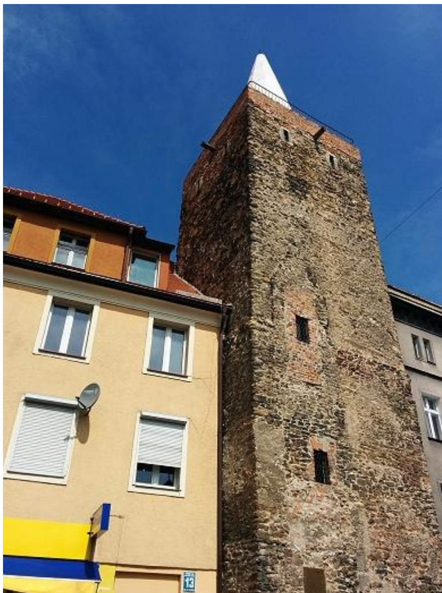
Fot. 2. Ogólny widok baszty z zewnątrz
