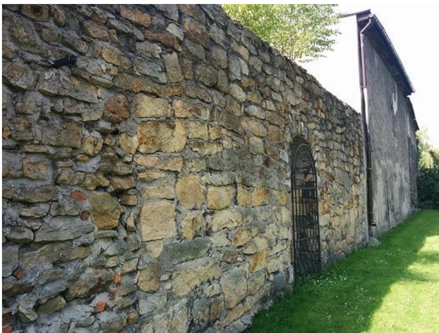
Fot. 25. Mur przy ul. Wojska Polskiego – widok ogólny
