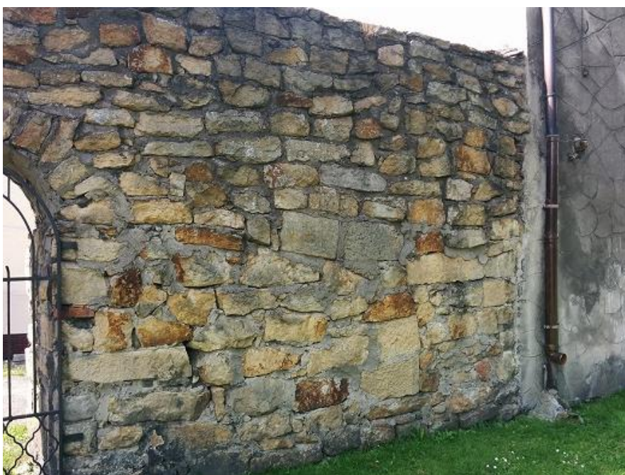
Fot. 26. Mur przy ul. Wojska Polskiego – widok ogólny
