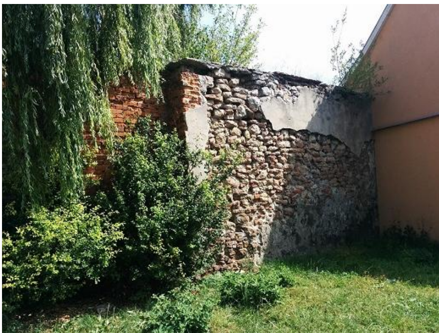
Fot. 33. Mur przy ul. Wojska Polskiego – widok ogólny
