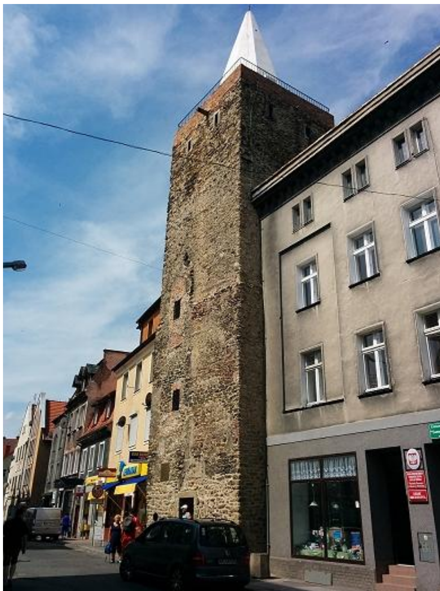
Fot. 1. Ogólny widok baszty z zewnątrz
