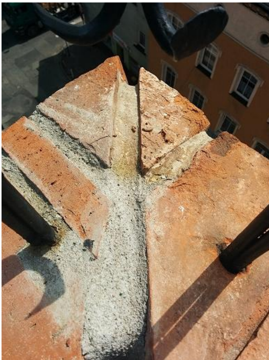
Fot. 10. Cementowa spoina założona podczas ostatniego remontu baszty
