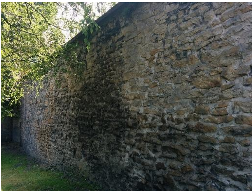
Fot. 21. Mur przy ul. Wojska Polskiego – widok ogólny
