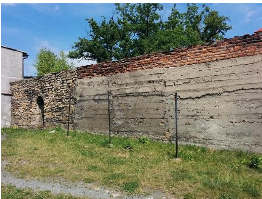
Fot. 36. Mur przy ul. Wojska Polskiego – widok ogólny
