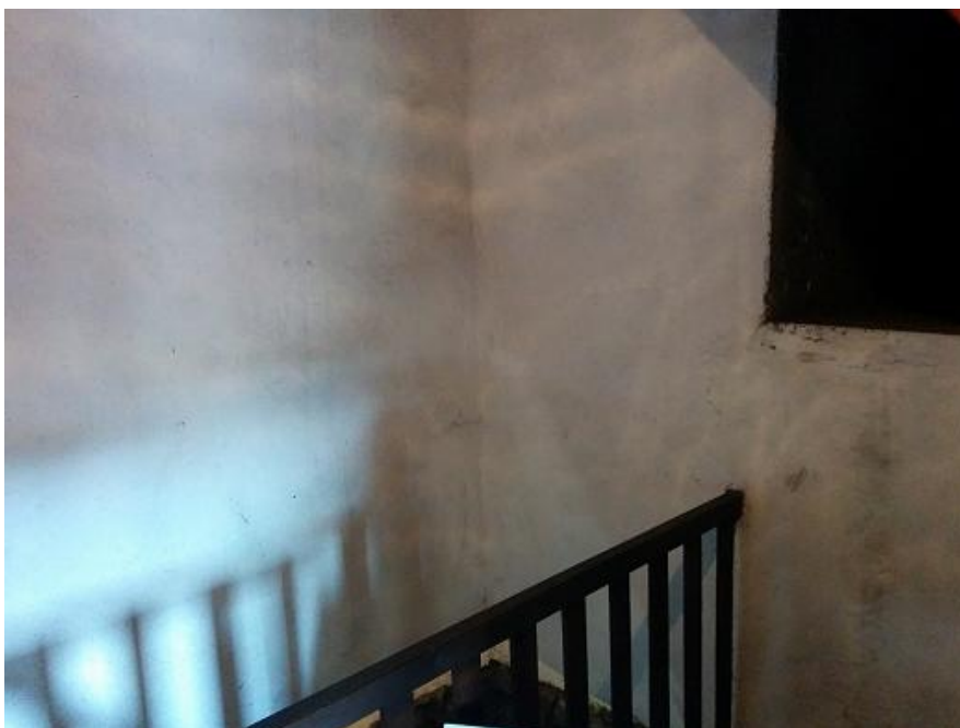
Fot. 15. Cementowe tynki pochodzące z ostatniego remontu wnętrza
