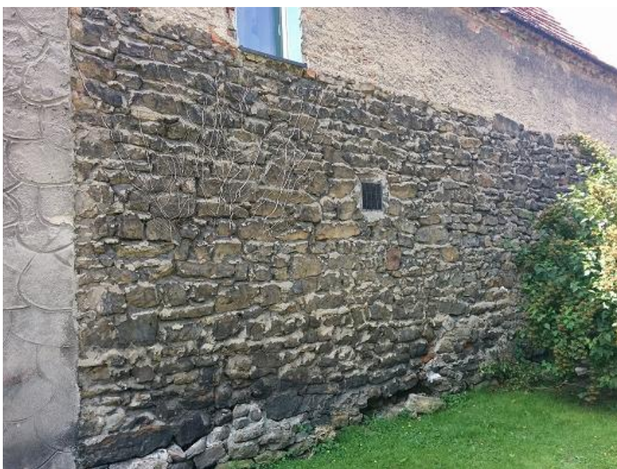
Fot. 28. Mur przy ul. Wojska Polskiego – widok ogólny
