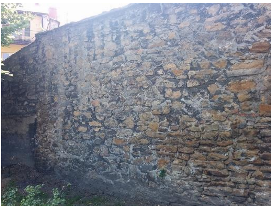
Fot. 20. Mur przy ul. Wojska Polskiego – widok ogólny
