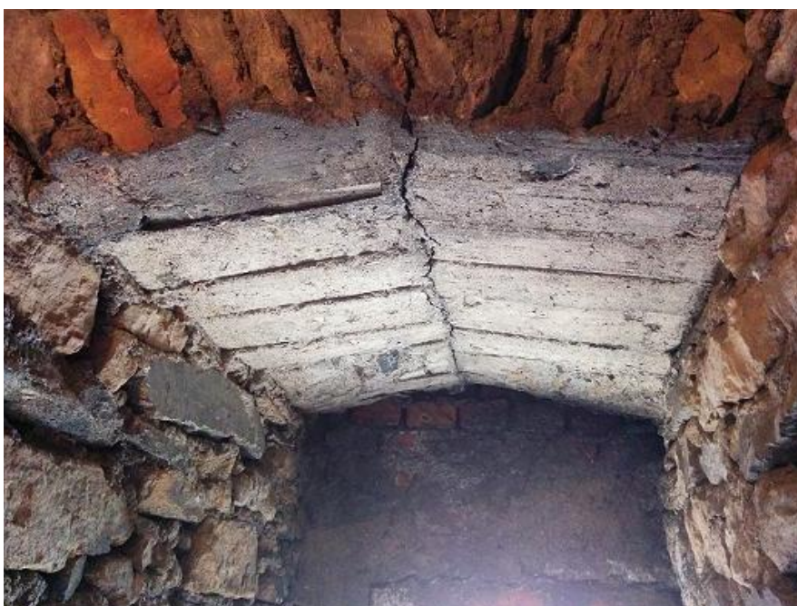
Fot. 16. Wtórne, cementowe sklepienie
