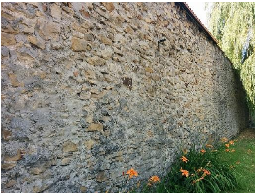
Fot. 23. Mur przy ul. Wojska Polskiego – widok ogólny
