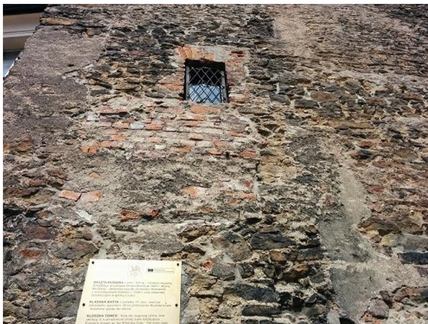
Fot. 5. Lico muru kamiennego – elewacja baszty. Widoczne wtórne przemurowania z cegły
