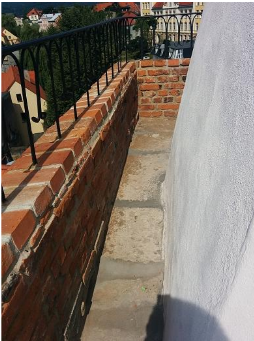
Fot. 9. Posadzka tarasu wieży – widoczne cementowe spoiny
