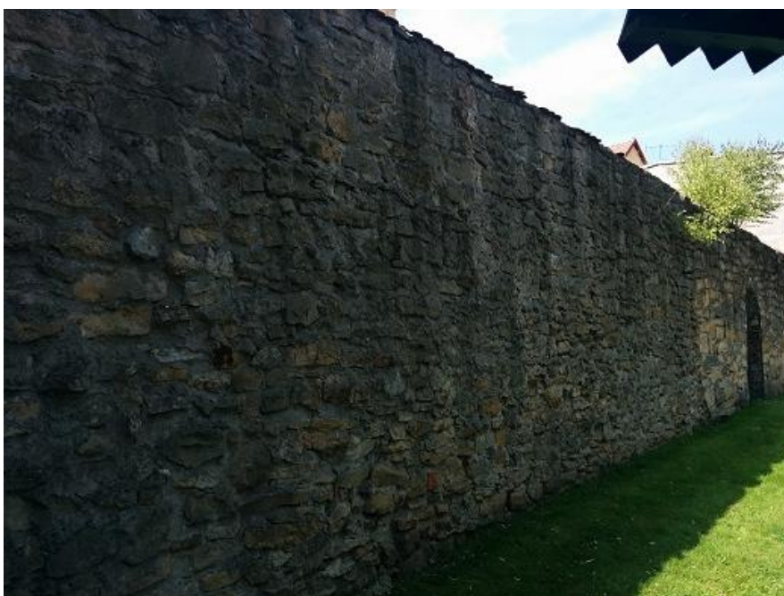
Fot. 24. Mur przy ul. Wojska Polskiego – widok ogólny
