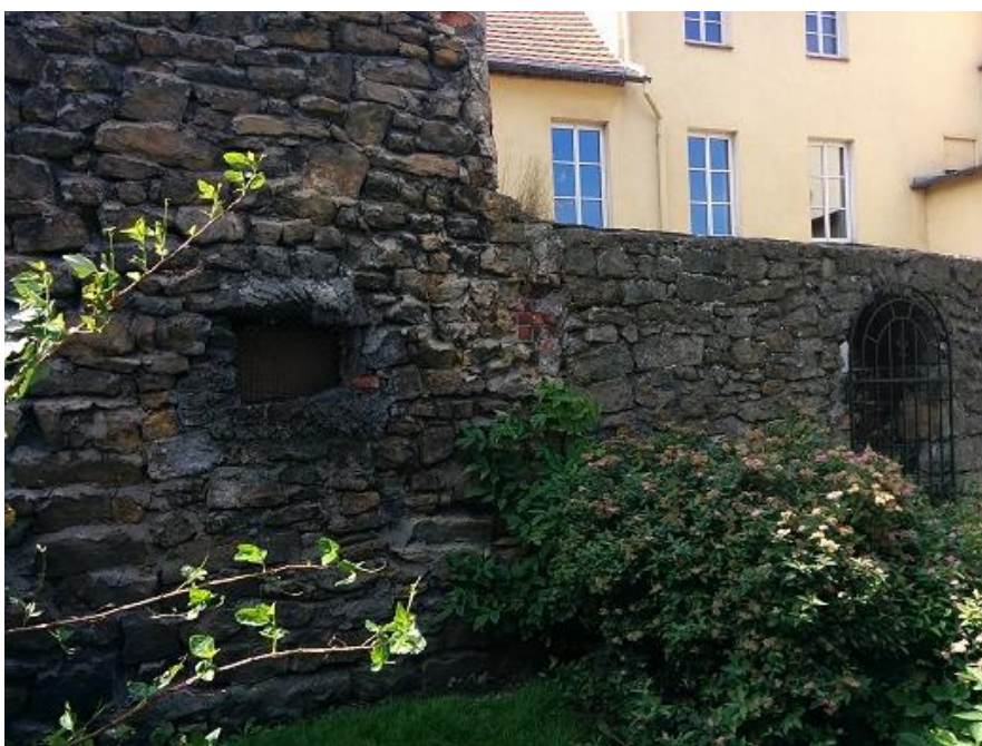
Fot. 30. Mur przy ul. Wojska Polskiego – widok ogólny
