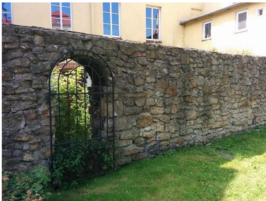
Fot. 31. Mur przy ul. Wojska Polskiego – widok ogólny
