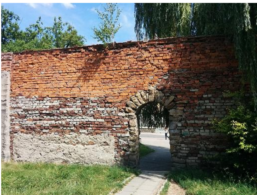
Fot. 34. Mur przy ul. Wojska Polskiego – widok ogólny
