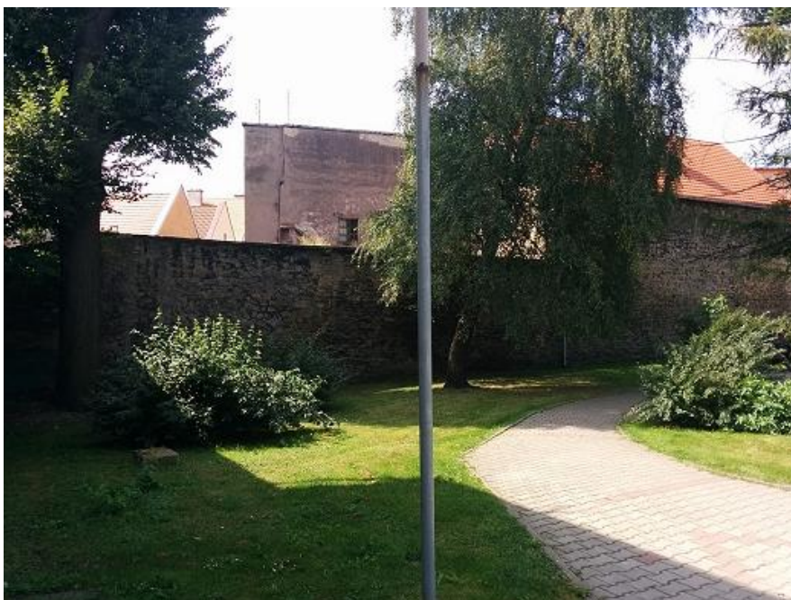
Fot. 19. Mur przy ul. Wojska Polskiego – widok ogólny
