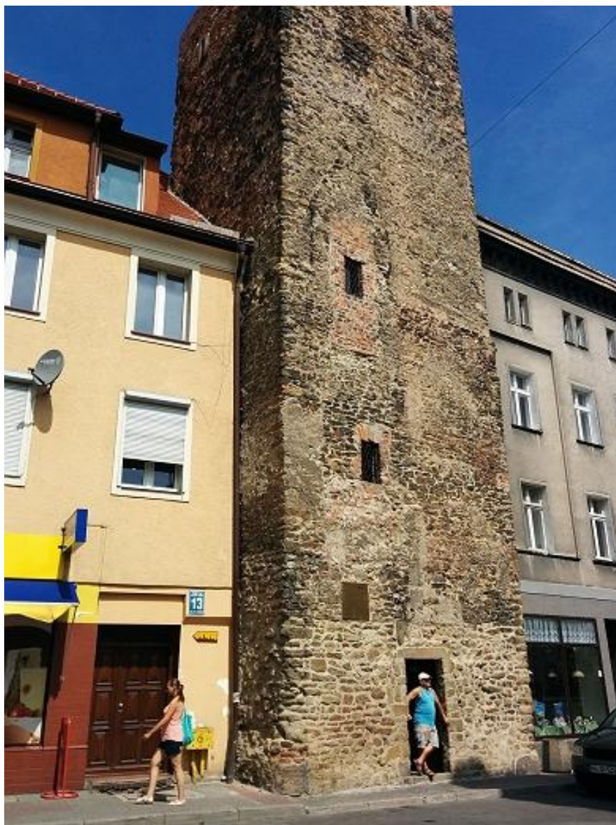
Fot. 3. Ogólny widok baszty z zewnątrz
