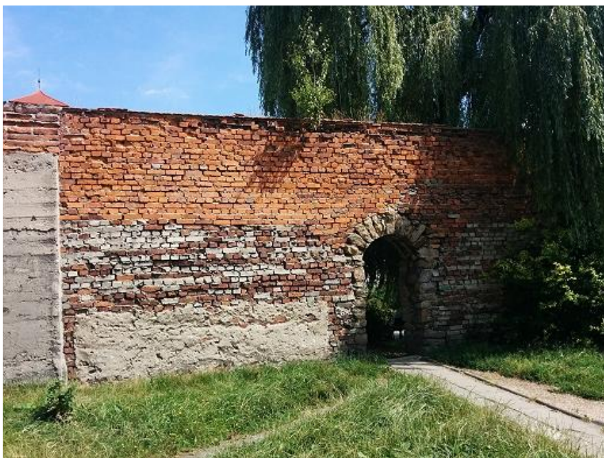
Fot. 35. Mur przy ul. Wojska Polskiego – widok ogólny
