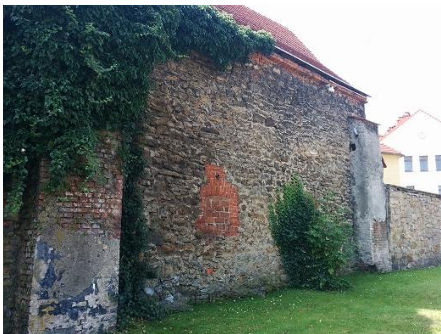
Fot. 32. Mur przy ul. Wojska Polskiego – widok ogólny
