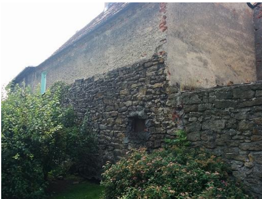
Fot. 29. Mur przy ul. Wojska Polskiego – widok ogólny
