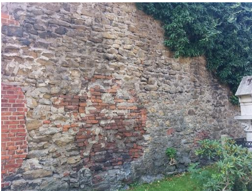
Fot. 51. Mur przy ul. Wojska Polskiego – wtórne naprawy cegłą
