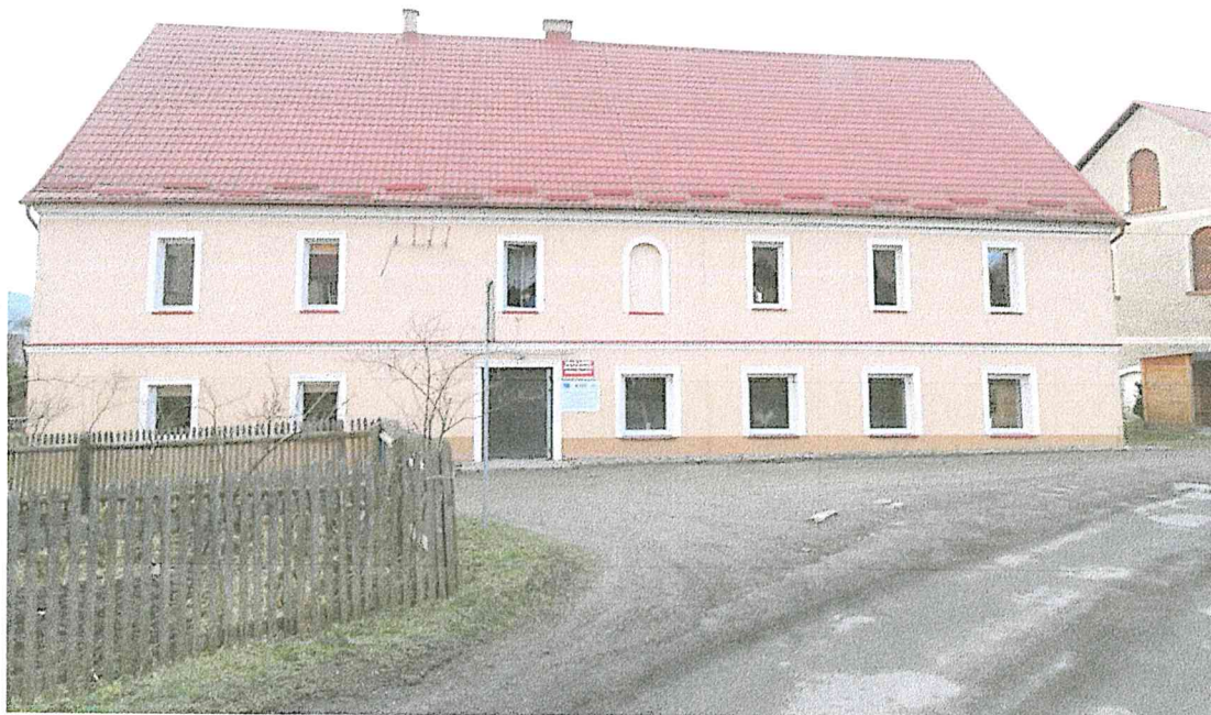
Widok budynku od strony północnej (elewacja frontowa).
