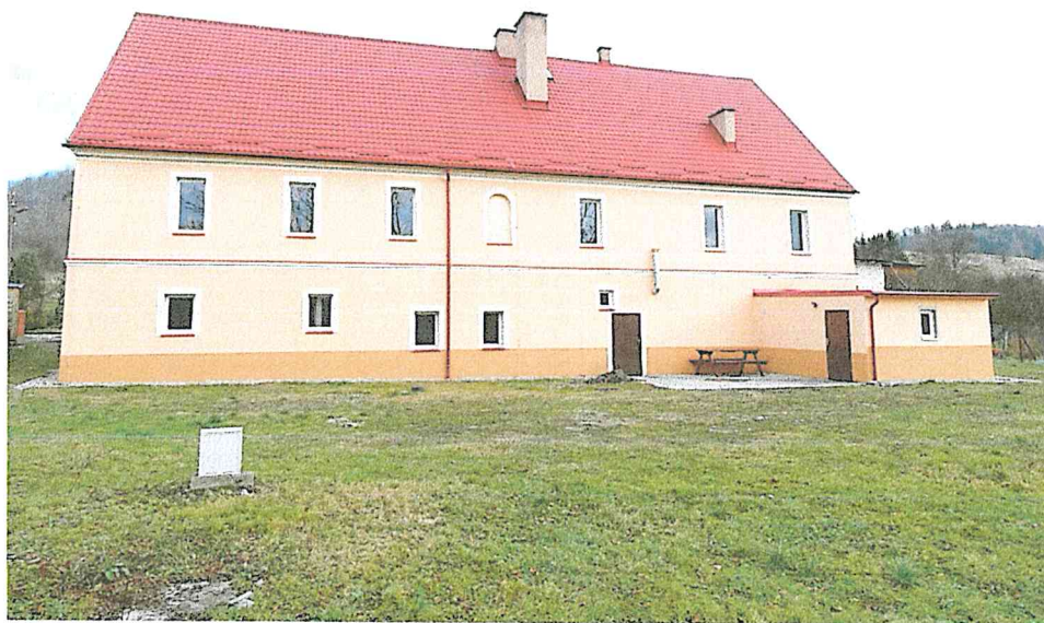
Widok budynku od strony wschodniej.
