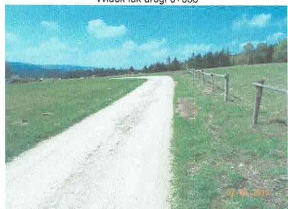
Widok łuk drogi 0+358
