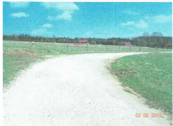
Widok łuk drogi 0+358
