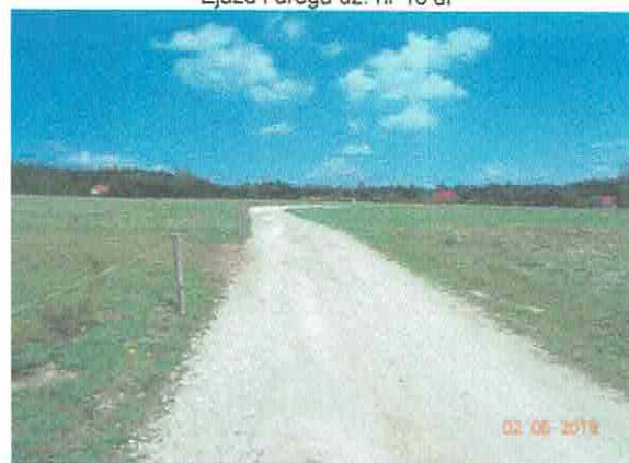
Widok łuk drogi 0+275
