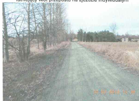
Widok drogi w miejscu mijanki
