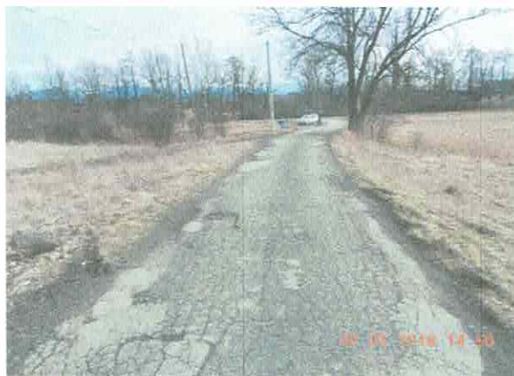
Widok w kierunku zjazdu z drogi powiatowej.
