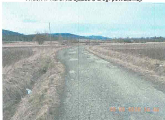
Widok drogi. Rów do czyszczenia i pogłębienia
