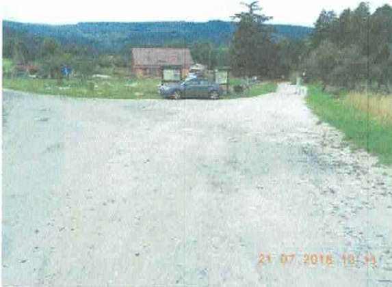
Zjazd z drogi powiatowej
