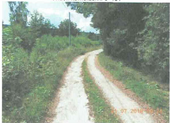
Widok nawierzchni i rowu 0+224
