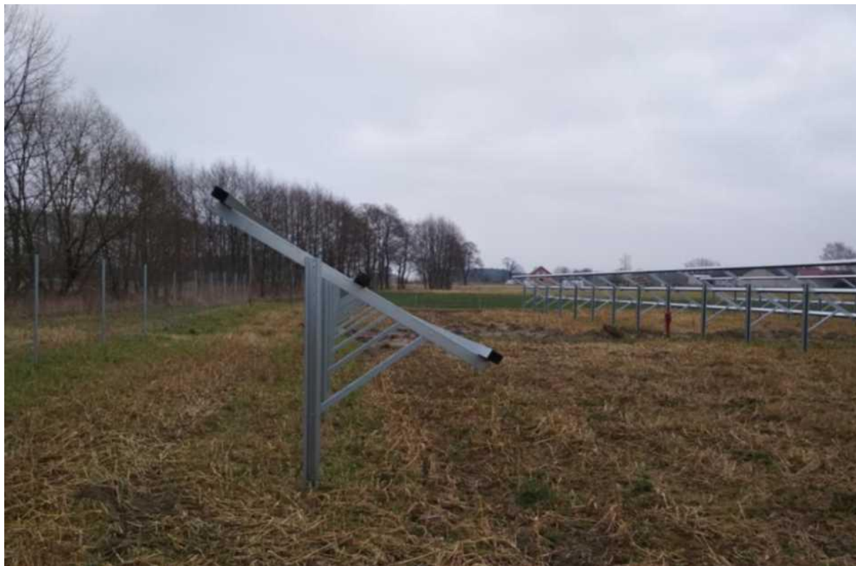
Ryc.4 Konstrukcje wsporcze przygotowane do montażu paneli fotowoltaicznych - widoczne kilkumetrowe odstępy między rzędami.
