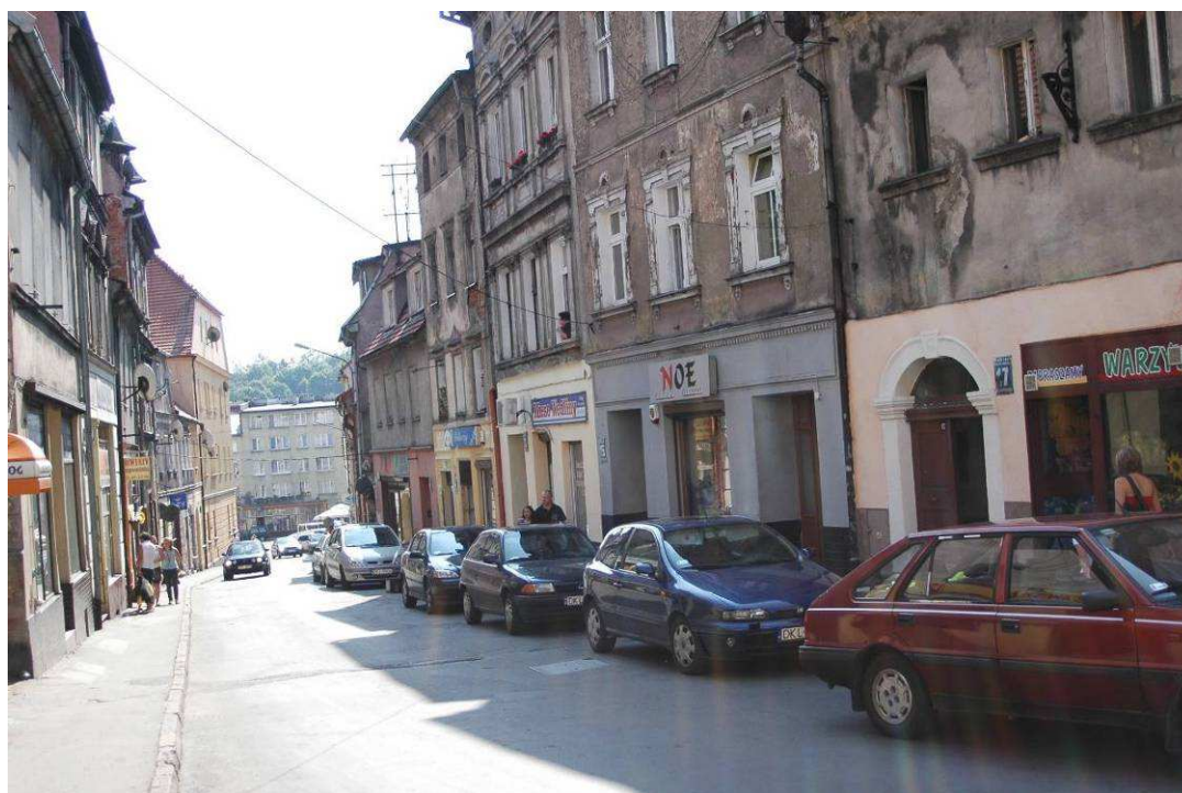
Fotografia 1. Asfaltowa nawierzchnia ulic i chodników w złym stanie technicznym. Zniszczone elewacje budynków – widoczne zawilgocenia murów i odpadający tynk
