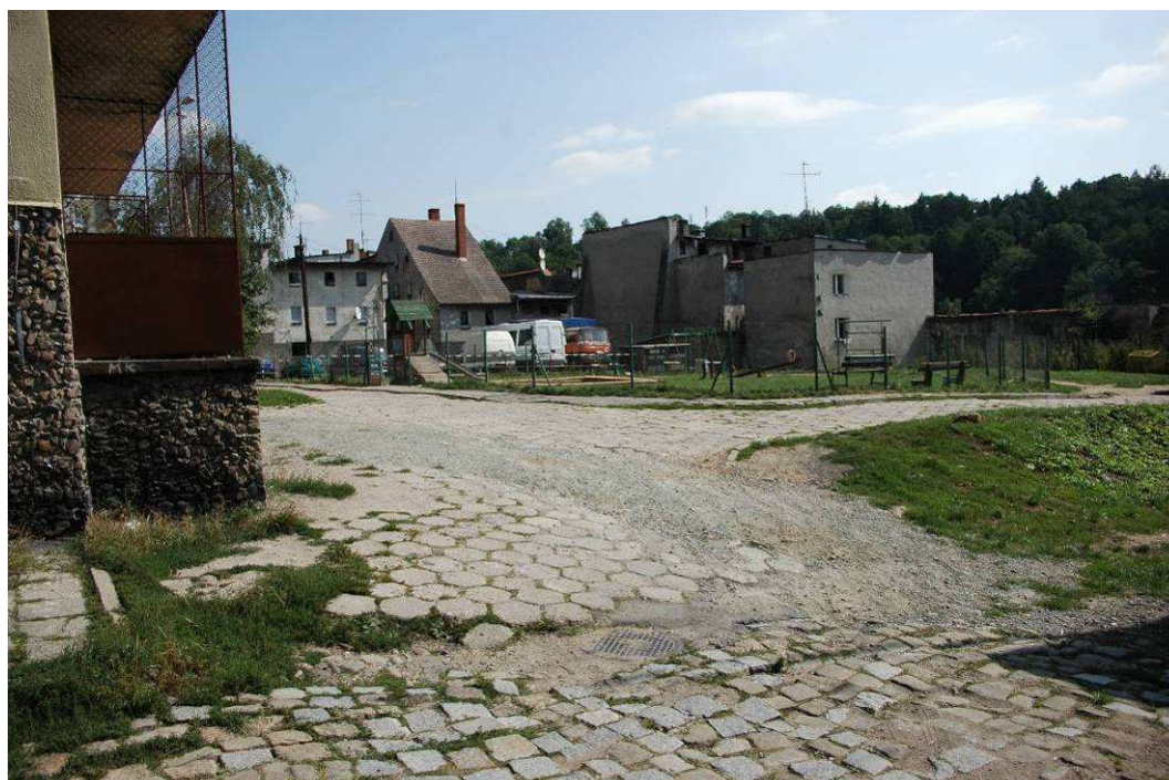
Fotografia 5. Źle zagospodarowane przestrzenie publiczne przy kamienicach (na tyłach), otoczenie placu edukacji ruchowej dla dzieci pokryte nierówną nawierzchnią z kostki betonowej i zaniedbaną zielenią
