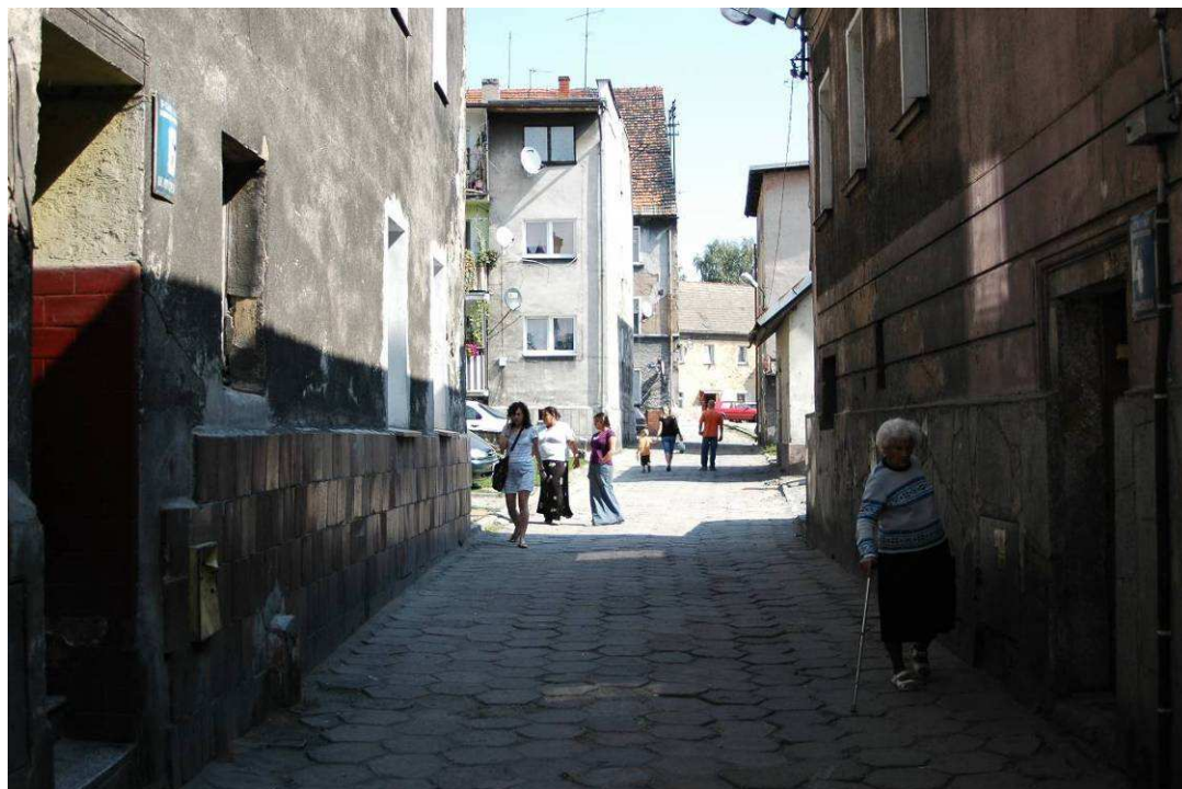
Fotografia 2. Ciąg pieszo-jezdny z kostki betonowej, nawierzchnia zniszczona i nierówna
