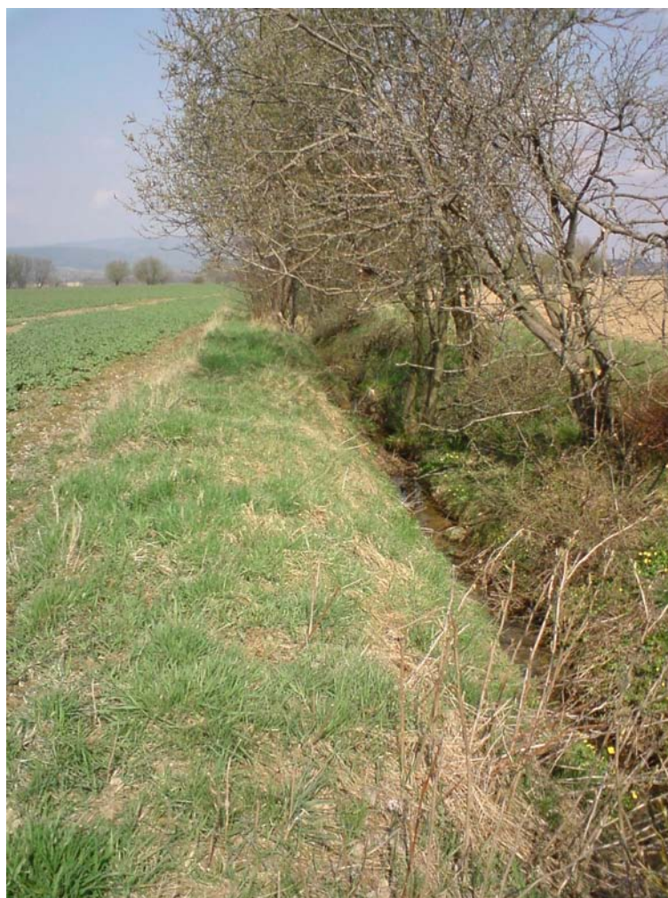
Fot. nr 14. Rów melioracyjny w Wilkanowie.
