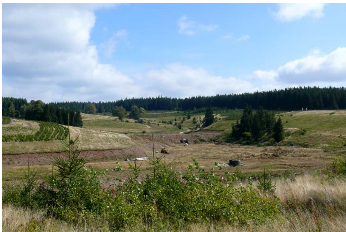
Fot. nr 5. Budowa zbiornika wodnego w Piaskowicach.
