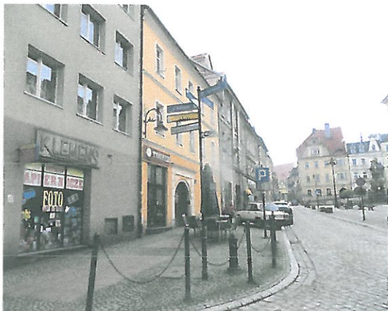
Fot.6 Droga dojazdowa Pl. Wolności+hydrant nadz,
