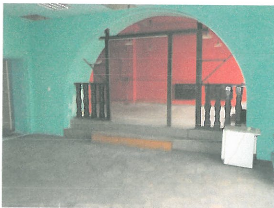
Fot.4 Pomieszczenia przewidziane do przebudowy.
