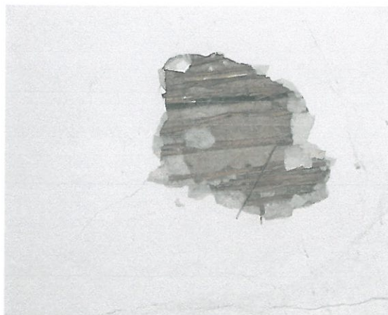
Fot.7 Strop płaski drewniany w części pomieszczeń wskazany do zabezpieczenia klasowego.
